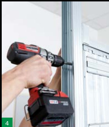
Připevnění pouzdra ke konstrukci SDK
