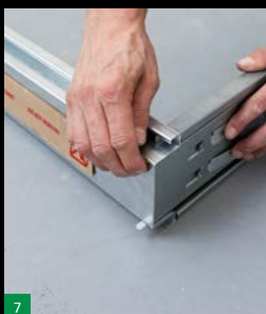
4 Vložte kolejnici s nadpražím do horní části pouzdra
